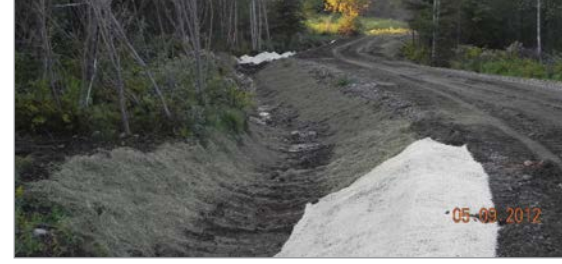
Des actions concrètes ont été réalisées en voirie forestière.
